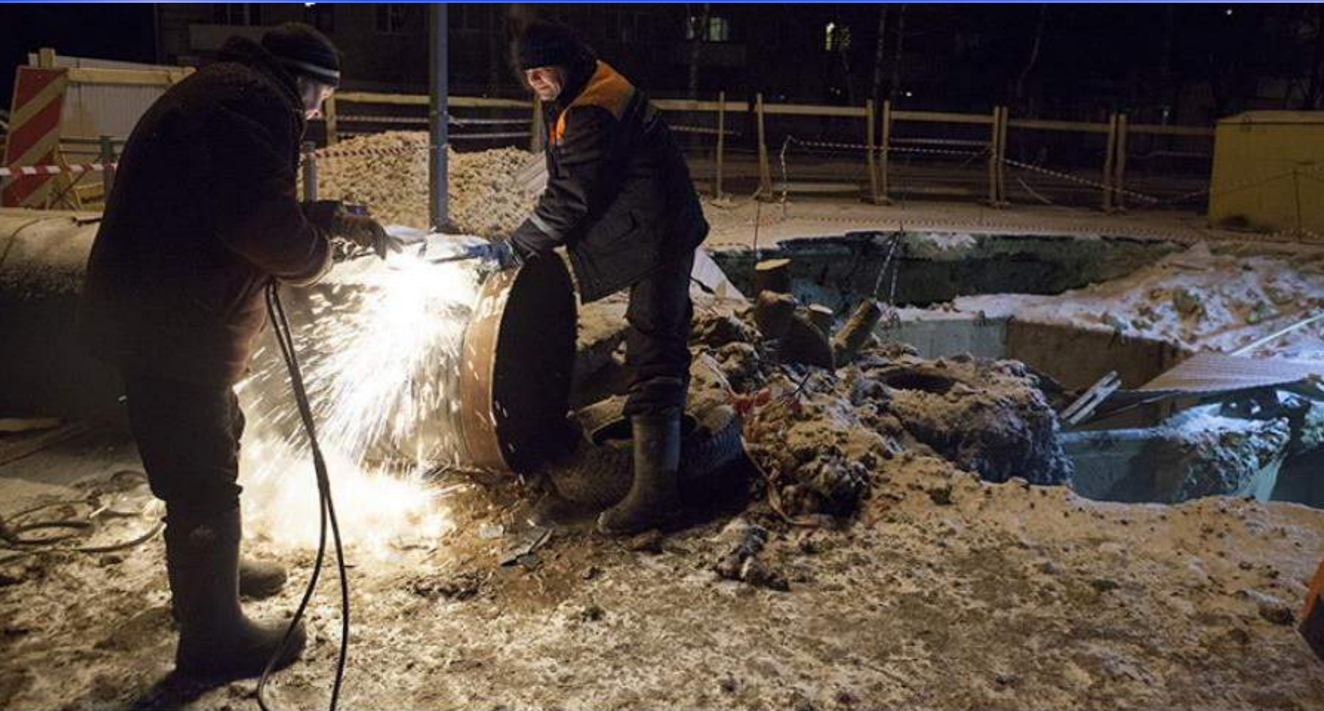
Ночной ремонт канализационного коллектора
